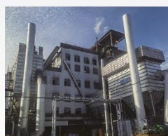
新疆天业40500KVA密闭电石炉厂房排烟除尘系统
