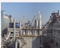
信发集团48000KVA密闭电石炉炉气净化回收系统
