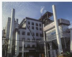
新疆天业40500KVA密闭电石炉厂房排烟除尘系统
