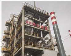
内蒙古君正81000KVA密闭电石炉炉气净化回收系统
