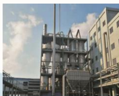
安徽华塑40500KVA密闭电石炉炉气净化回收系统
