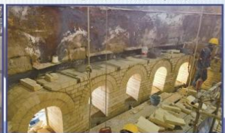
300T/D双梁石灰窑施工现场
