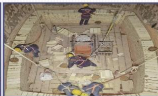
600TPD吨双梁石灰窑施工
