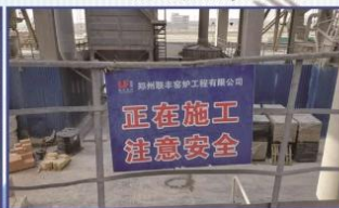
185T/D石灰窑施工现场
