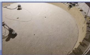
54000KVA电石炉内衬砌筑
