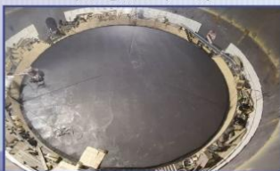
48000KVA电石炉炉底碳砖施工
